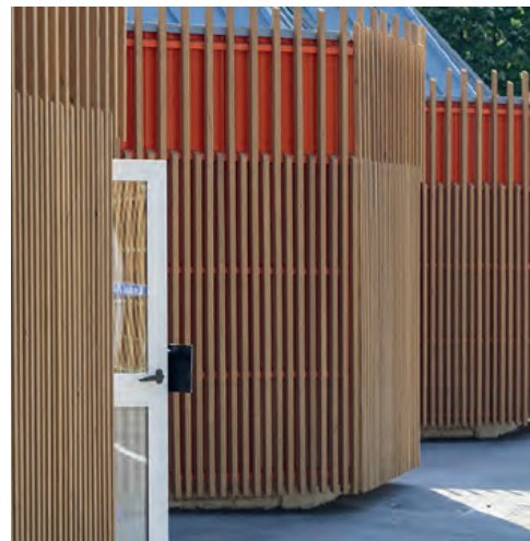
Rénovation du groupe scolaire de Lugny - 2022
