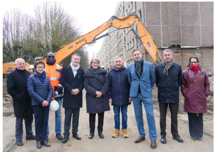
La démolition a débuté en présence des élus de Moissy et des partenaires : la Préfecture de Seine-et-Marne, l'agglomération Grand Paris Sud et le bailleur Habitat 77, le 9 février 2026.
