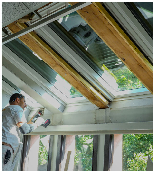
Remplacement des velux aux Marronniers.
