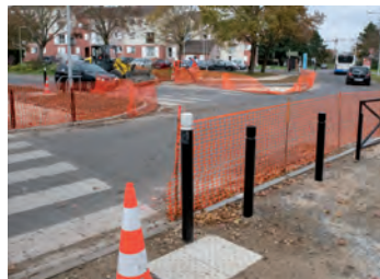
Réfection du carrefour d'Arvigny et de la Mare l'Evêque (coût 92 000 €).
