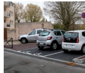
Réalisation d'une place PMR, rue Fructidor (35 000 €).
